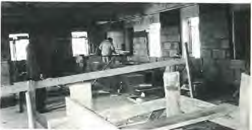
Anche l'ex granaio viene isolato con una parete di forattine e stiferite.
