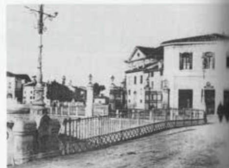
Il ponte "nuovo", ora Garibaldi, ed il fabbricato della barriera. Da notare i fanali per l'illuminazione con i tralicci a croce per appoggiare la scala per l'accensione.
