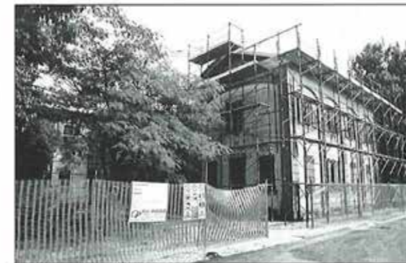
Il cantiere A.N.A. di Oderzo
